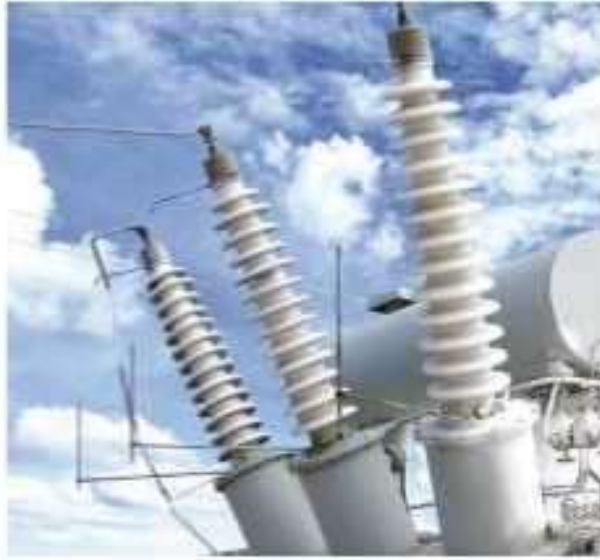
پوشینگ پوشش داده شده روی ترانسفورماتور در منطقه ساحلی
